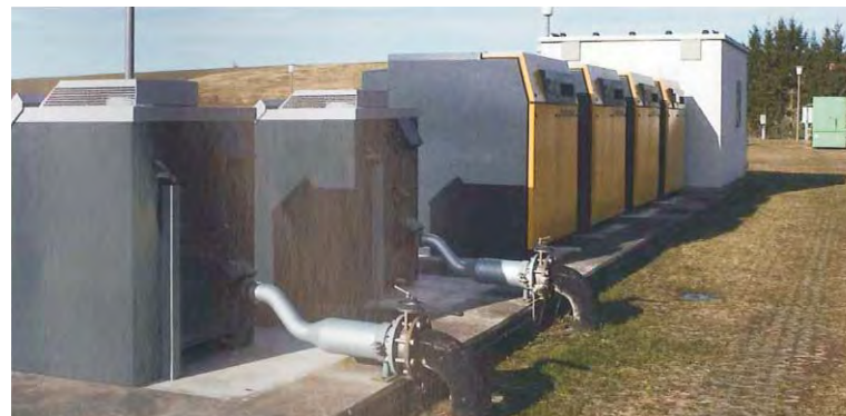
▪ Soplantes suministran elixir de vida para las bacterias de la planta depuradora: cantidades ingentes de oxígeno
