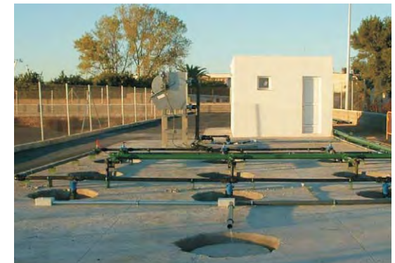
▪ La colocación enterrada de los reactores evita la percepción visual
