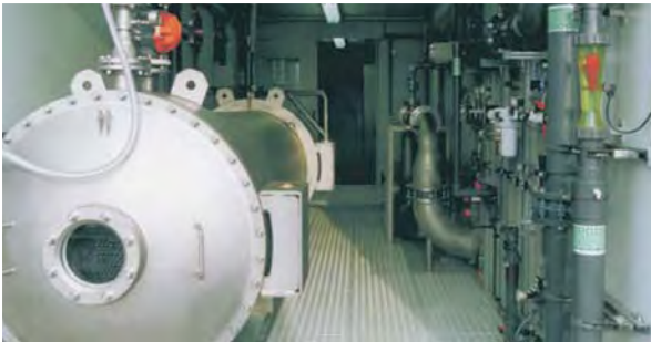
■ Planta de ozono para oxidación de flujo parcial de agua residual
