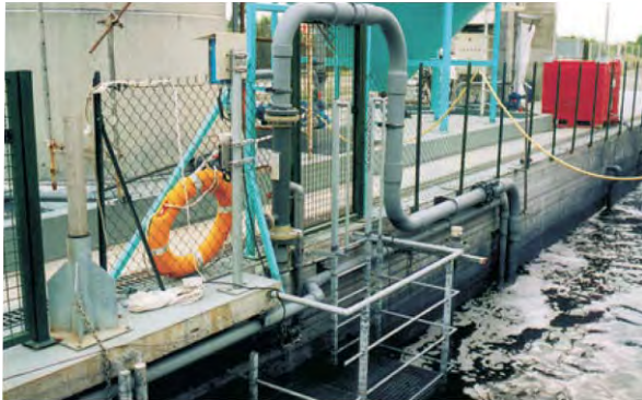
■ Neutralización con CO 2 de agua residual alcalina de la industria textil
